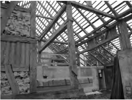
Wirtschaftsteil mit Brettern verschaltete Holzkonstruktion
